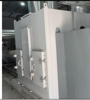
三级干式过滤+沸石转轮+T0燃烧装置
