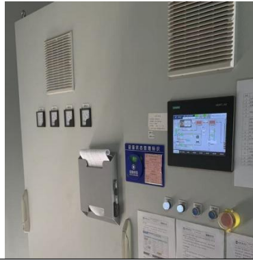
三级干式过滤+沸石转轮+T0燃烧装置
