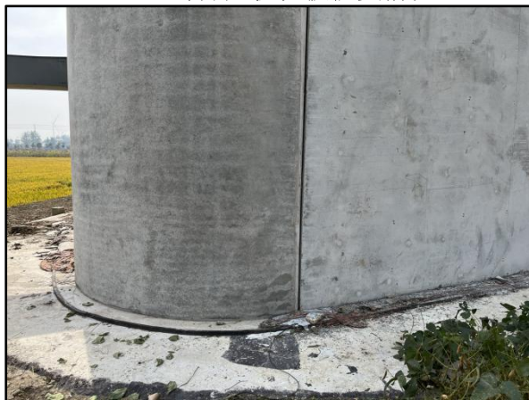
风机水土保持现状
