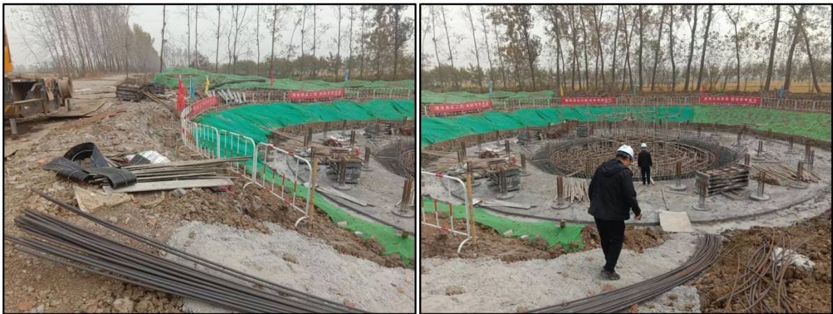
施工过程中防尘
