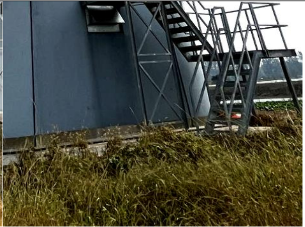
10#风机植被恢复情况
