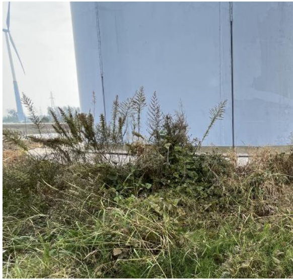
22#部分风机植被恢复情况
