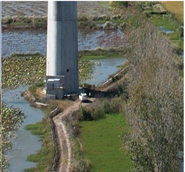
9#风机植被恢复情况
