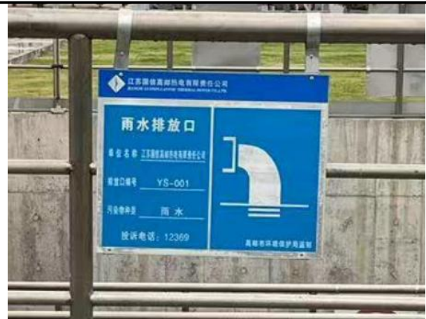
雨水排放口标识牌
